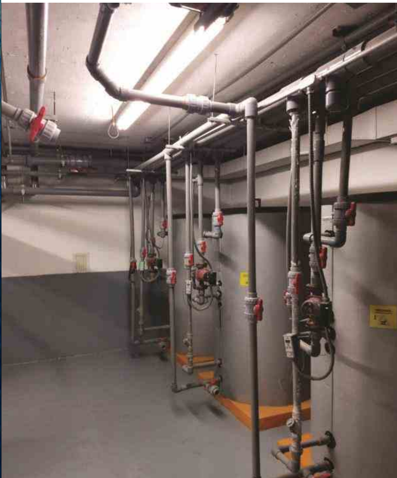
Instalación de Tanques de agua caliente Bosch en Villa del Arco
